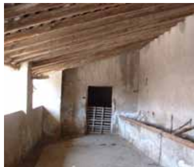
La copertura con travi in legno di una stalla
