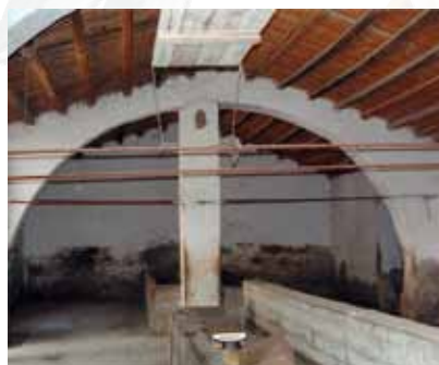
L'interno di una stalla con struttura ad arco
