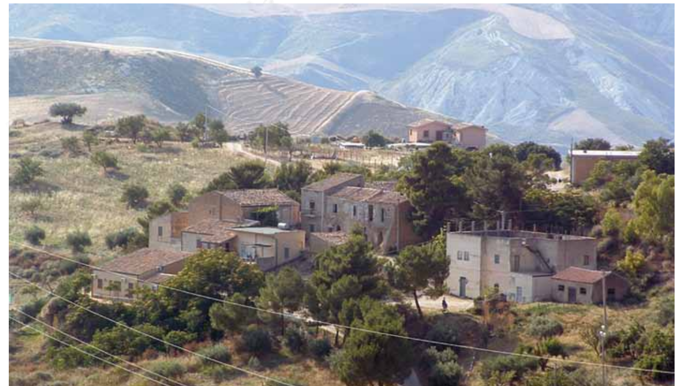
Il corpo ristrutturato a valle della masseria
