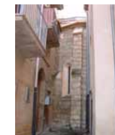
I contrafforti dell'edificio e una stretta finestra decorata con vetro colorato
