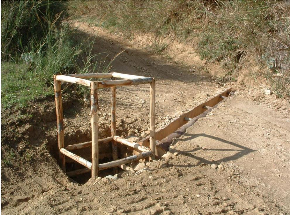
**Foto 17- Il sistema canaletta- pozzetto di laminazione su una strada bianca.**
