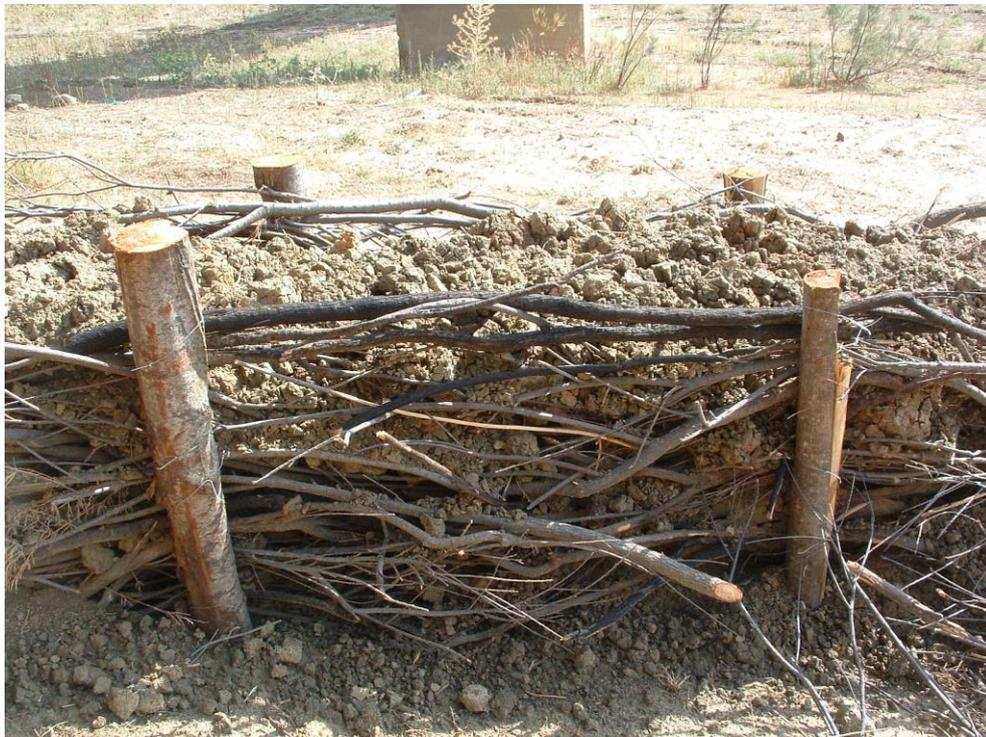
***Foto 44-45- “Repellente vivo per aree di ristagno”, vista della sistemazione di fascine di canne e tamerici e di terra agraria, che alla fine ricoprirà tutto il repellente.***
