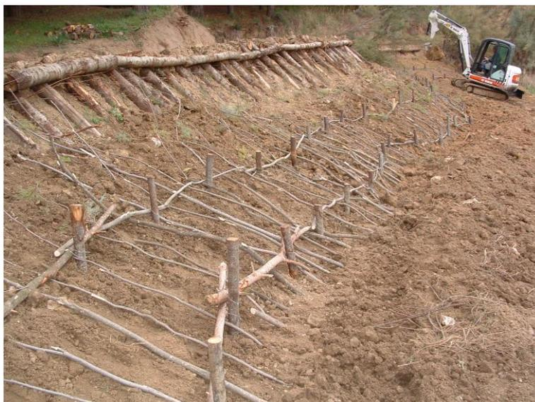
**Foto 37-38-39- “Copertura diffusa con astoni”:** in alto posizionamento degli astoni, al centro e in basso una sistemazione sotto la “Palificata spondale” .
