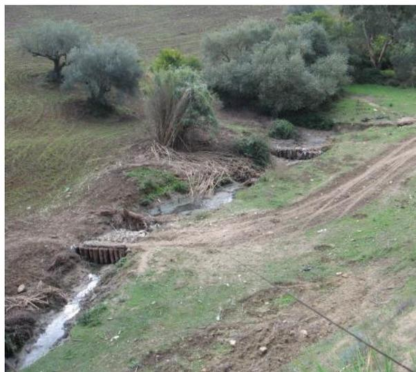
*Foto 64- Sistema filtrante con gabbioni e fascine di alberi e canne in alveo.*
