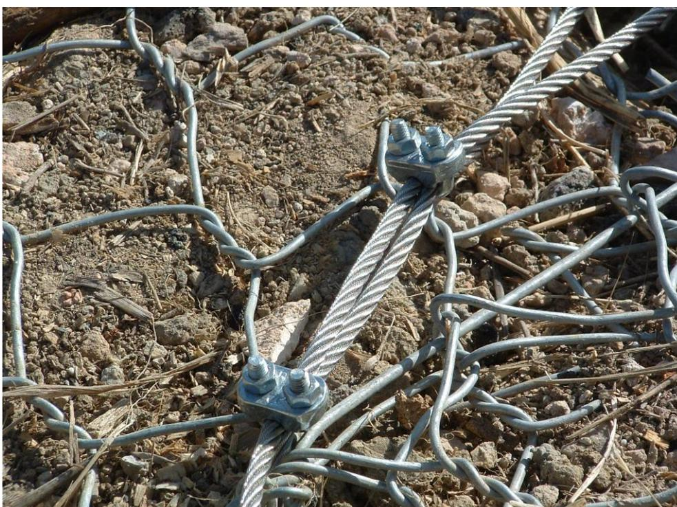
***Foto 57-58- Sopra, il sacco ricoperto di terra agraria e il lagunaggio a monte dello stesso; sotto, i cavi di acciaio che ancorano il sacco alle sponde.***
