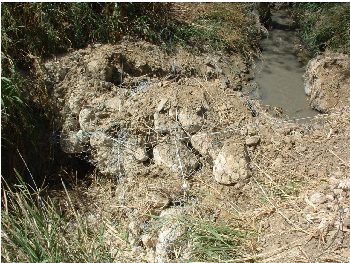
*Foto 56- Sacco percolatore messo in opera con ancoraggi in cavi di acciaio .
