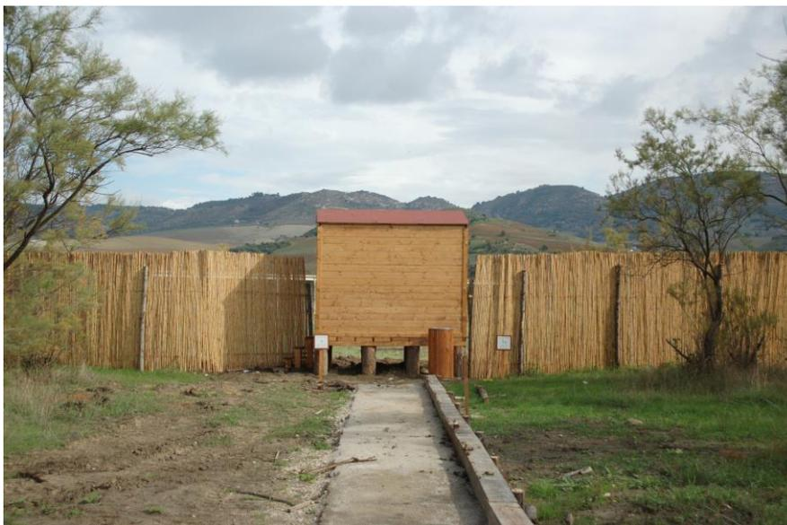
**Foto 27- Sentiero per portatori di handicap con pavimentazione ecologica e guide in tronchi di legno nei pressi di un capanno di osservazione.**
