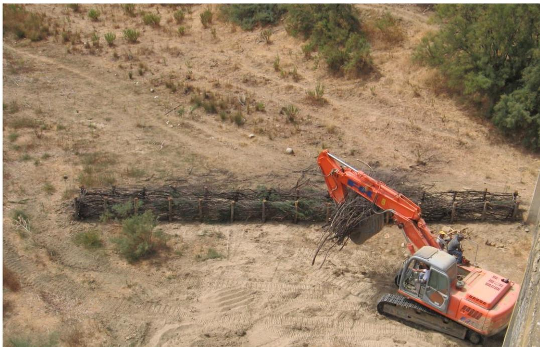
**Foto 43- “Repellente vivo per aree di ristagno”, sistemazione di fascine di canne e tamerici da legare con fil di ferro ai pali.**
