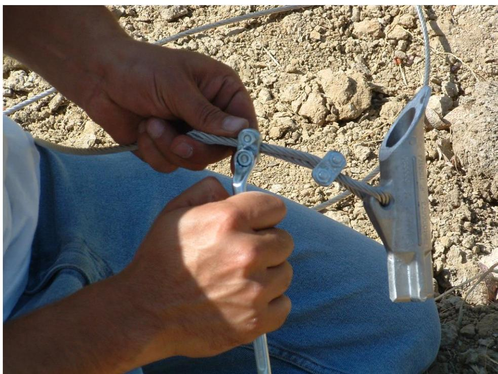
**Foto 59-60- Sopra, l'elemento da fissare al cavo d'acciaio e successivamente infiggere nel terreno; sotto, il fissaggio con il cavo d'acciaio.**
