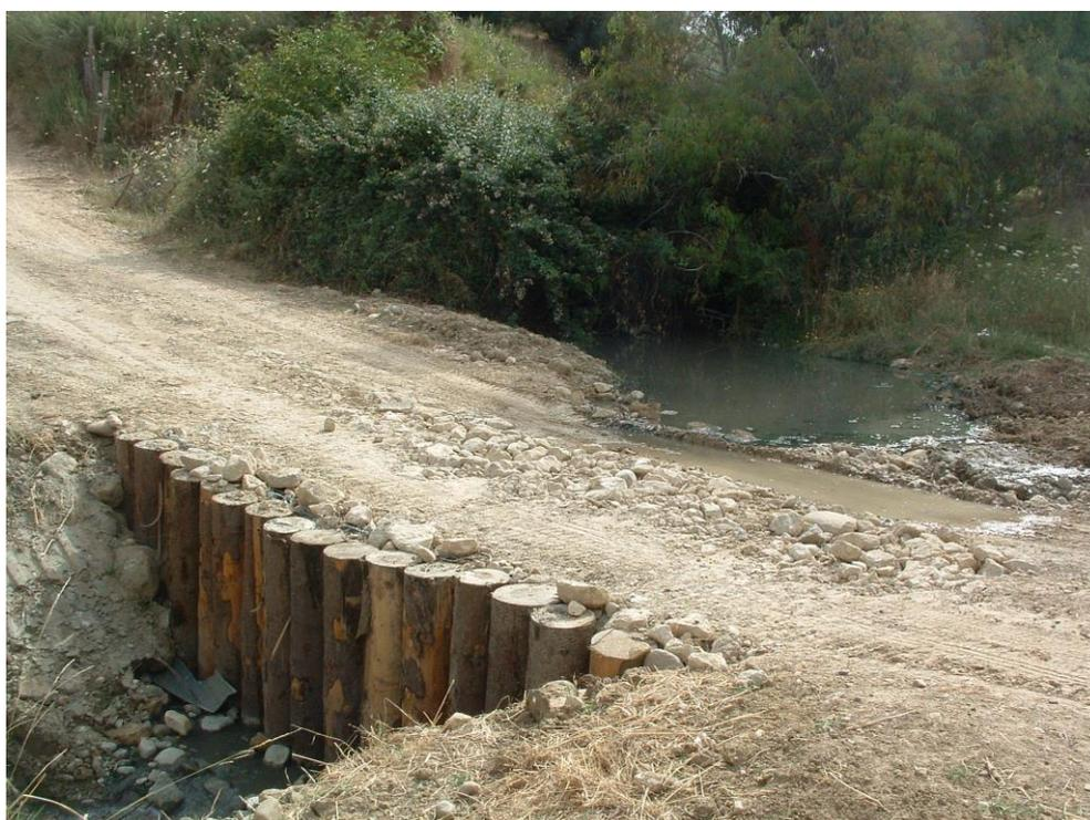
*Foto 16- Attraversamento a raso sul Torrente Mastrosilvestro.
