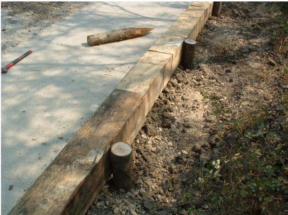
**Foto 26- Posizionamento e fissaggio dei tronchi con paletti in legno e chiodi ai lati della pavimentazione ecologica.**
