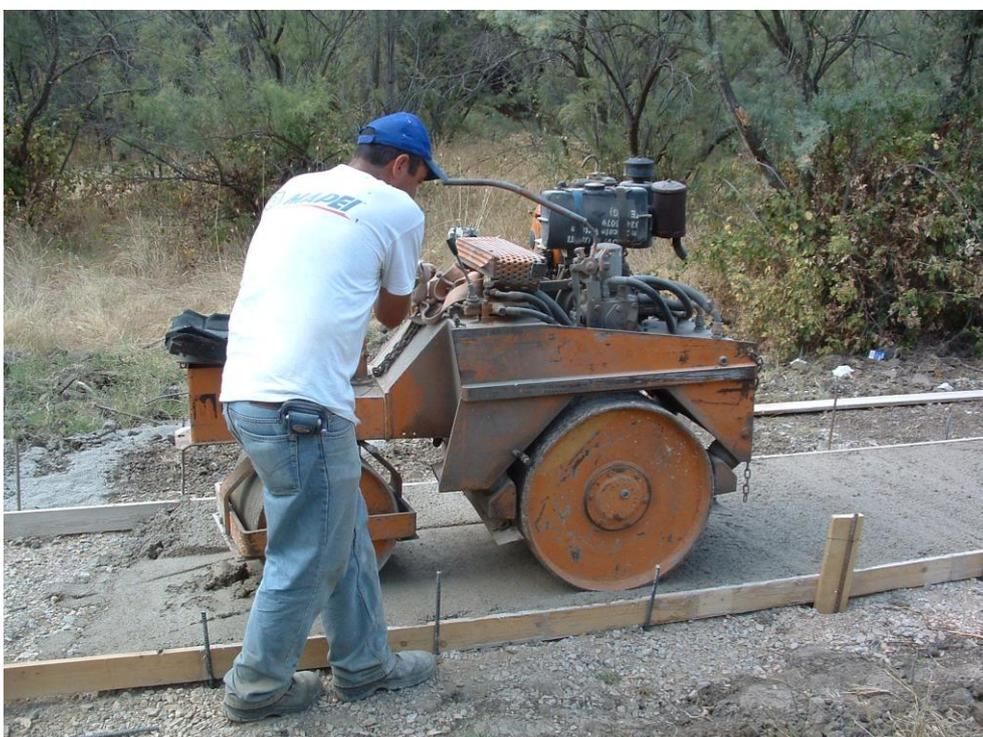
**Foto 24- Costipamento del getto con piccolo rullo compressore.**
