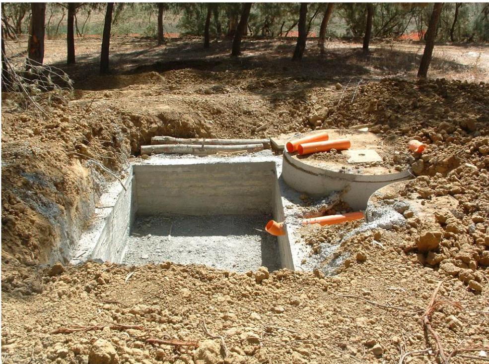
*Foto 10- Il sistema Fossa Imhoff- Letto assorbente nel momento della costruzione.
