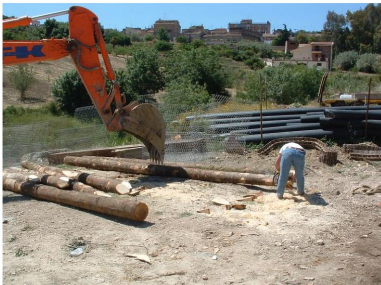
*Foto 61- Preparazione delle punte dei tronchi per l'infissione nel terreno.
