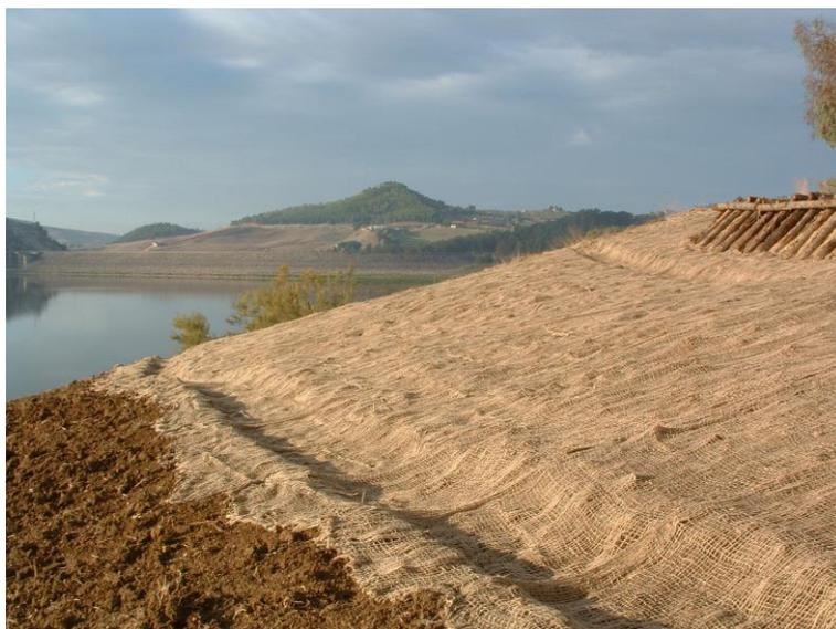
**Foto 40-41-42- “Rivestimento dei pendii con biostuoia in juta”:** in alto e al centro nei pressi del vivaio, in basso sotto un capanno di osservazione.
