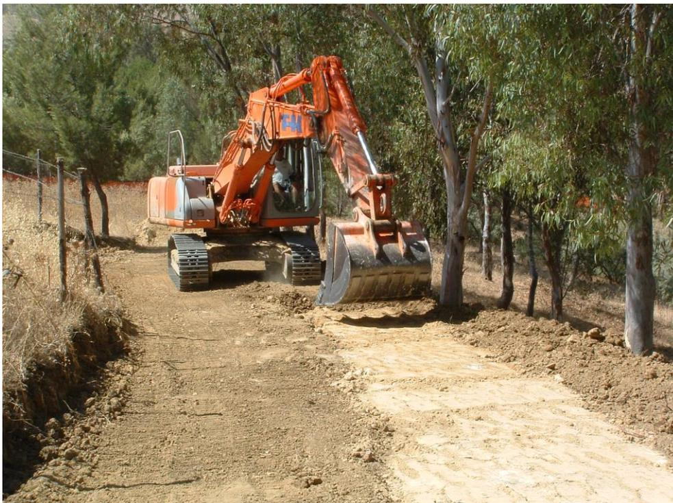
**Foto 21- Preparazione del sentiero per portatori di handicap con tout-venant di cava dello spessore di 50 cm .**
