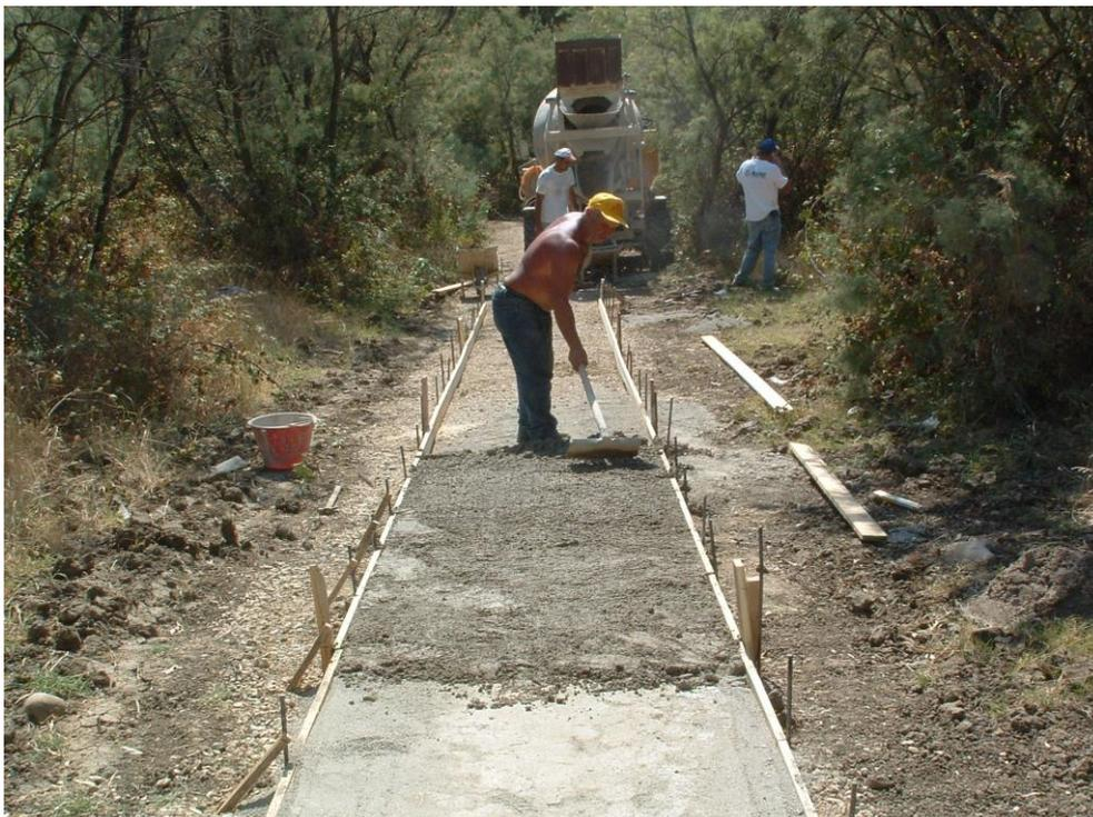
**Foto 23- Primo costipamento del getto della pavimentazione ecologica.**
